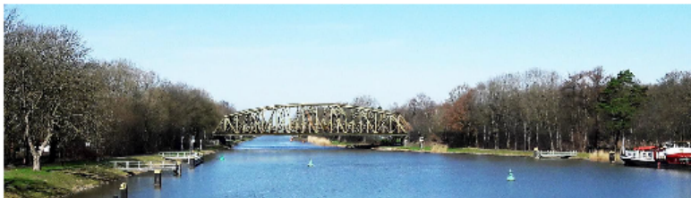
Die Eisenbahnüberführung über den Dortmund-Ems-Kanal muss erneuert werden. Hierbei wird außerdem die Durchfahrthöhe für Schiffe um 3,4 Meter vergrößert (April 2016) [Quelle: DB Netz AG/Rebecca Carrizosa]
